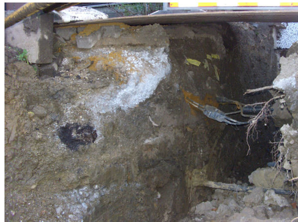
Abb. 2: Arbeiten an Versorgungsleitungen führen zu Bodenumlagerungen und Beimengungen neuer Substrate (2010, T. KASIELKE).
