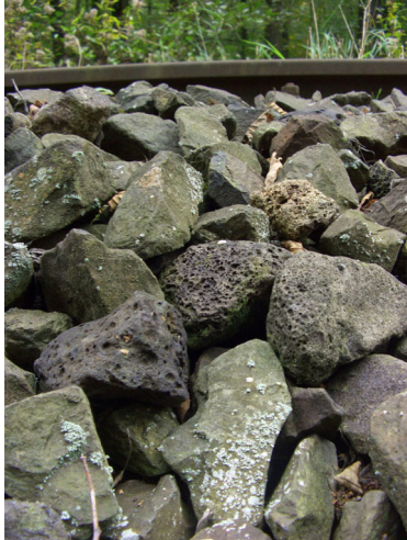
Abb. 20: Gleisschotter aus gebrochenem Naturstein und Hochofenschlacke (2010, T. KASIELKE).
